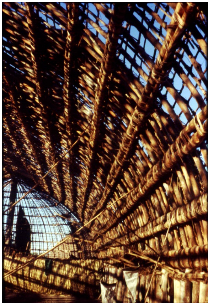
Detalhe de uma casa em construção na aldeia kamaiurá. Foto do autor (1981)
