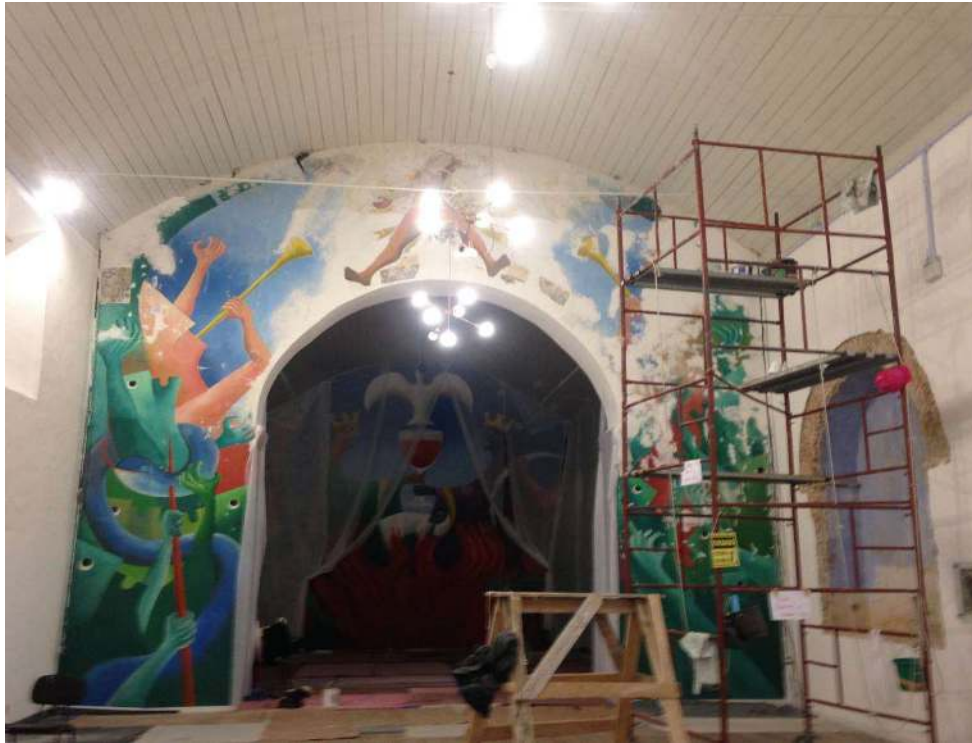
Imagem 69 - Nivelamento da pintura mural com massa mineral.
