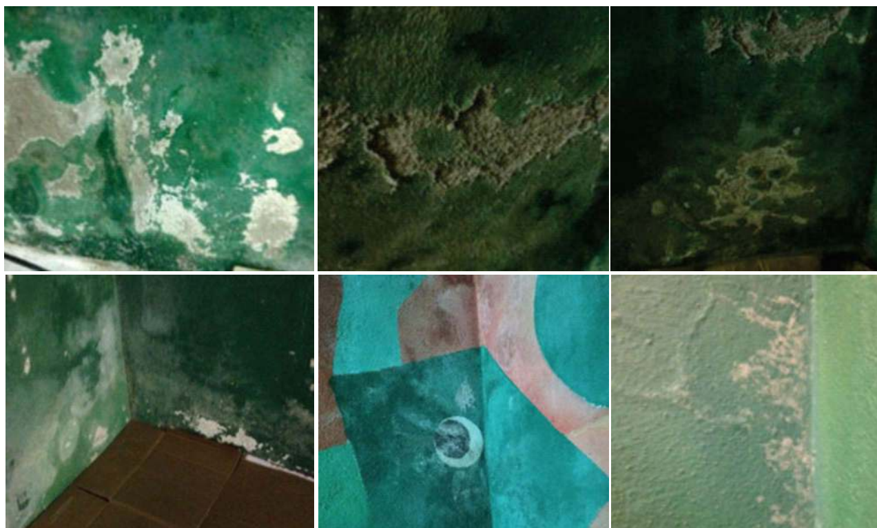
Imagem 135 - Eflorescência de sais no canto inferior e na lateral direita da parede ( próximo ao fundo da Capela-Mor).
