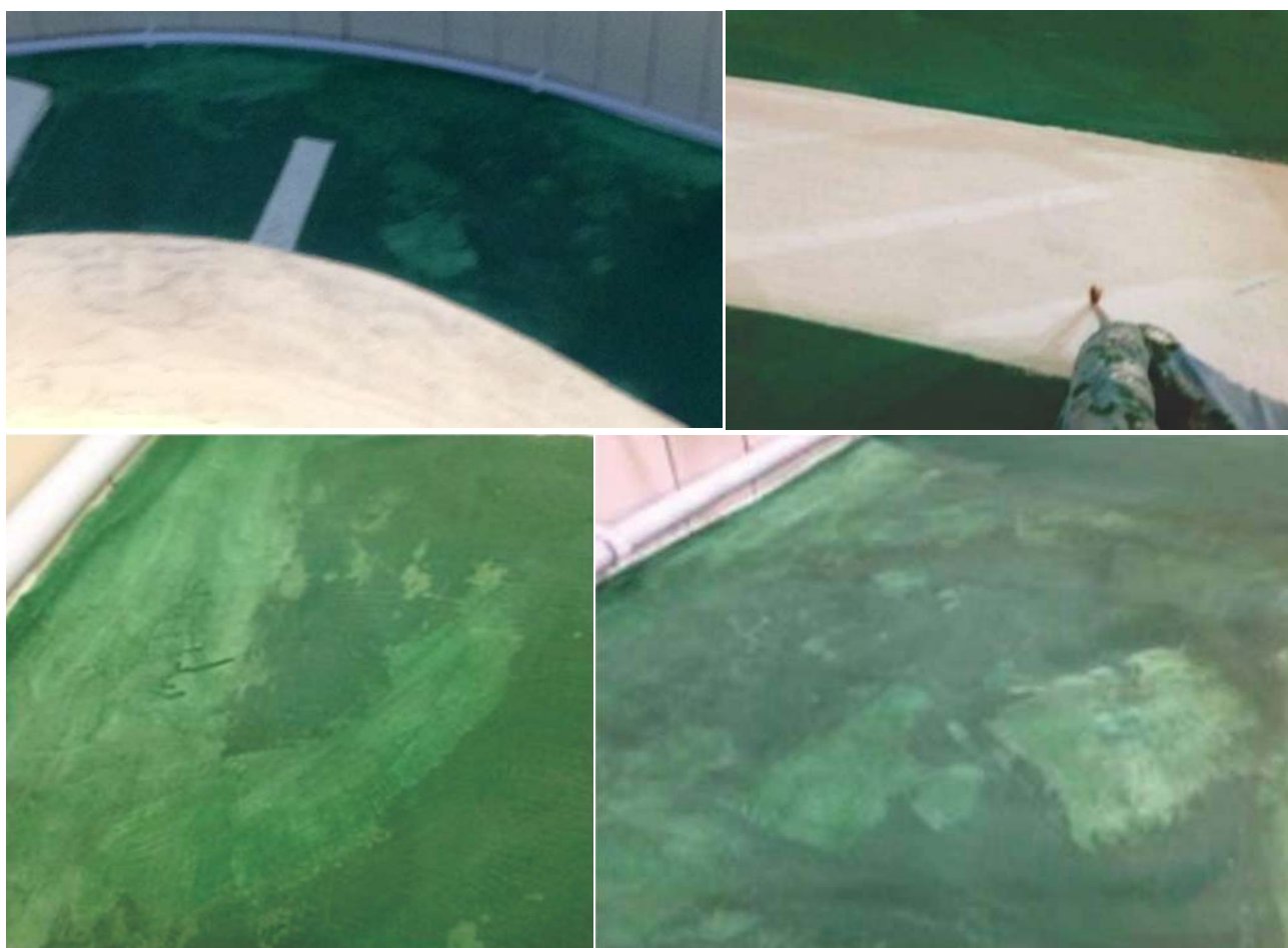
Imagem 126 - Detalhe: 1ª camada fina de tinta de restauro Charbonnel.
