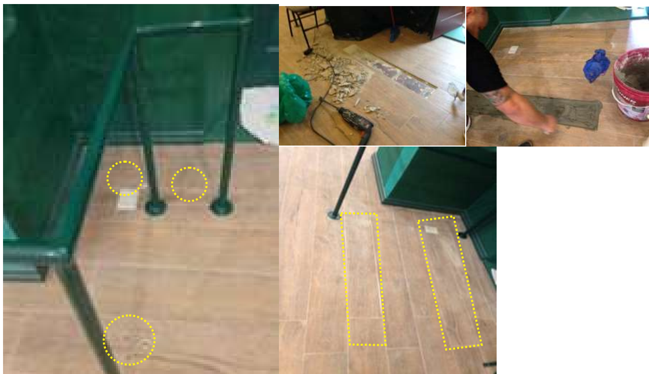
Imagem 225 - Retirada do guarda-corpo e substituição do 02 pisos danificados ( perfuração).
