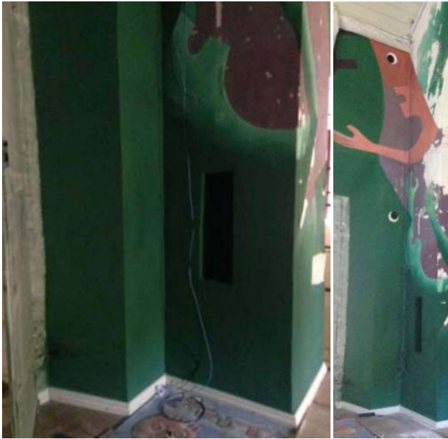
Imagem 128 - Fixação do rodapé de madeira .
