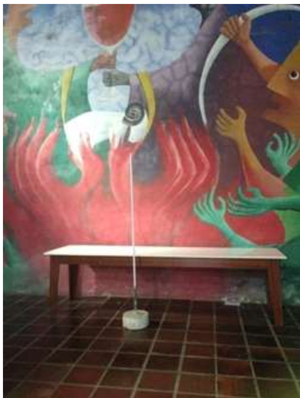
Imagem 165 - Material encostado no mural – causando patologias e deterioração do Mural.
