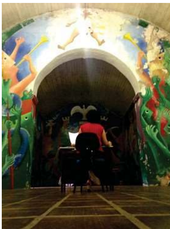
Imagem 54 - Diagnóstico do Arco Cruzeiro - Parede Nordeste - Interna
