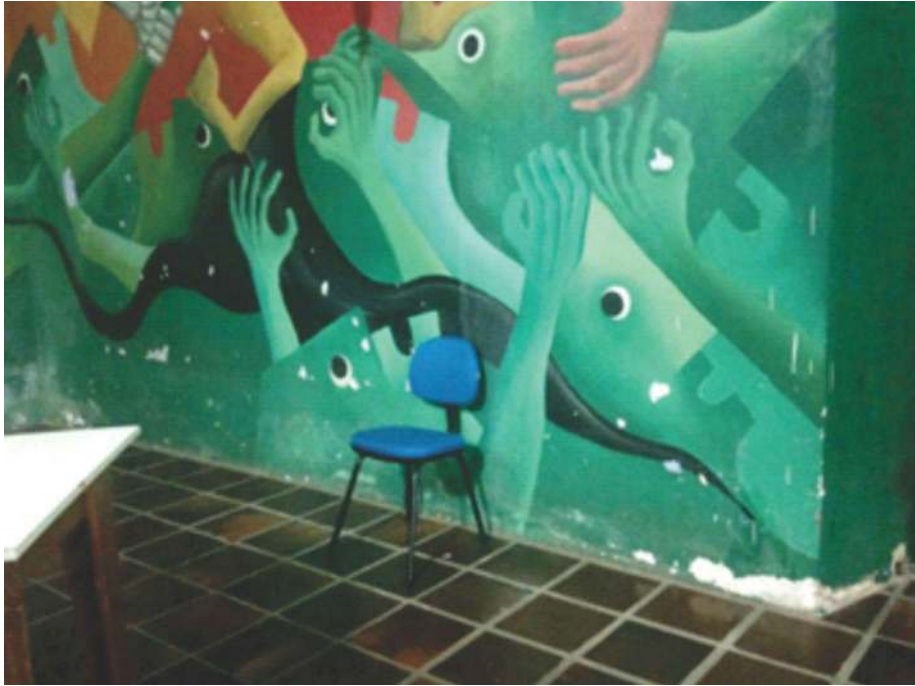
Imagem 192 - Material encostado no mural – causando patologias e deterioração do Mural.
