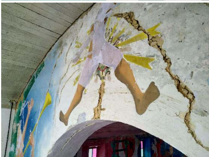
Imagem 38 - Teste de faceamento emergencial.
