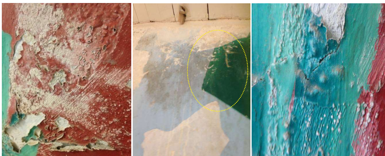
Imagem 60 - Áreas com pulverulência e fungos sobre a pintura mural - parede do Arco Cruzeiro .
