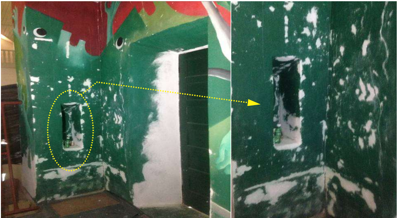
Imagem 125 - Áreas de intervenção (fissuras e lacunas) com nivelamento que receberá a reintegração cromática.
