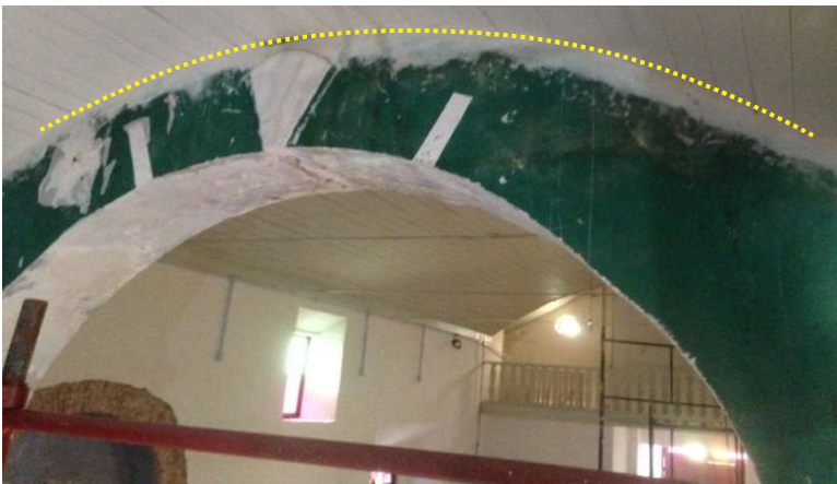
Imagem 113 - Argamassa de cimento
