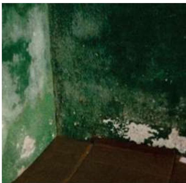
Imagem 166 - Presença de eflorescência de sais na lateral esquerda da parede (fundos da Capela - Mor).
