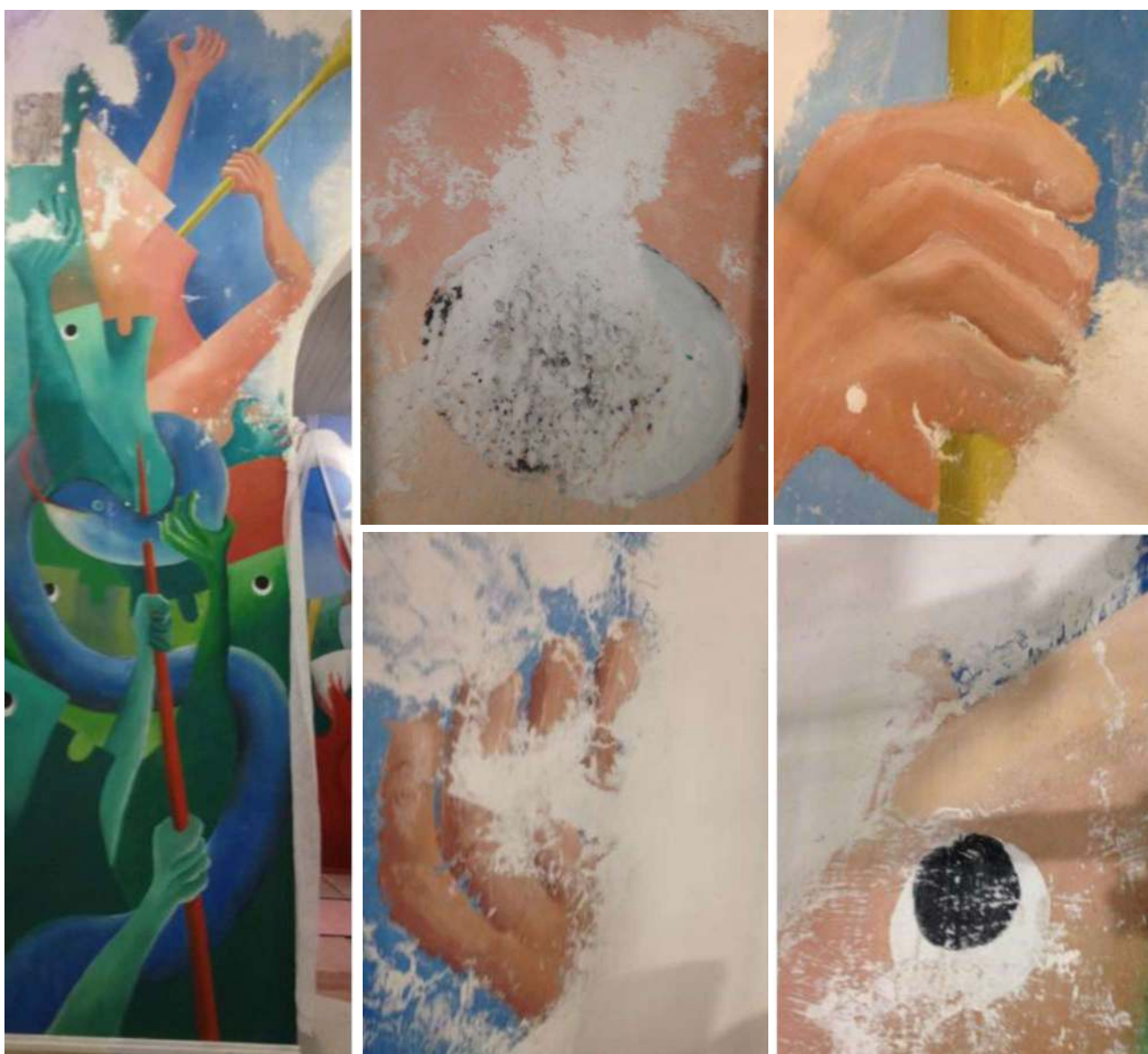
Imagem 75 - Nivelamento das áreas de intervenção com massa mineral (empresa Kröten).
