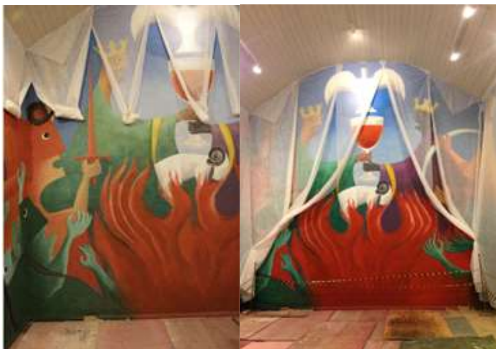
Imagem 182 - Colocação do TNT para proteção das áreas já tratadas (área superior do Mural).
