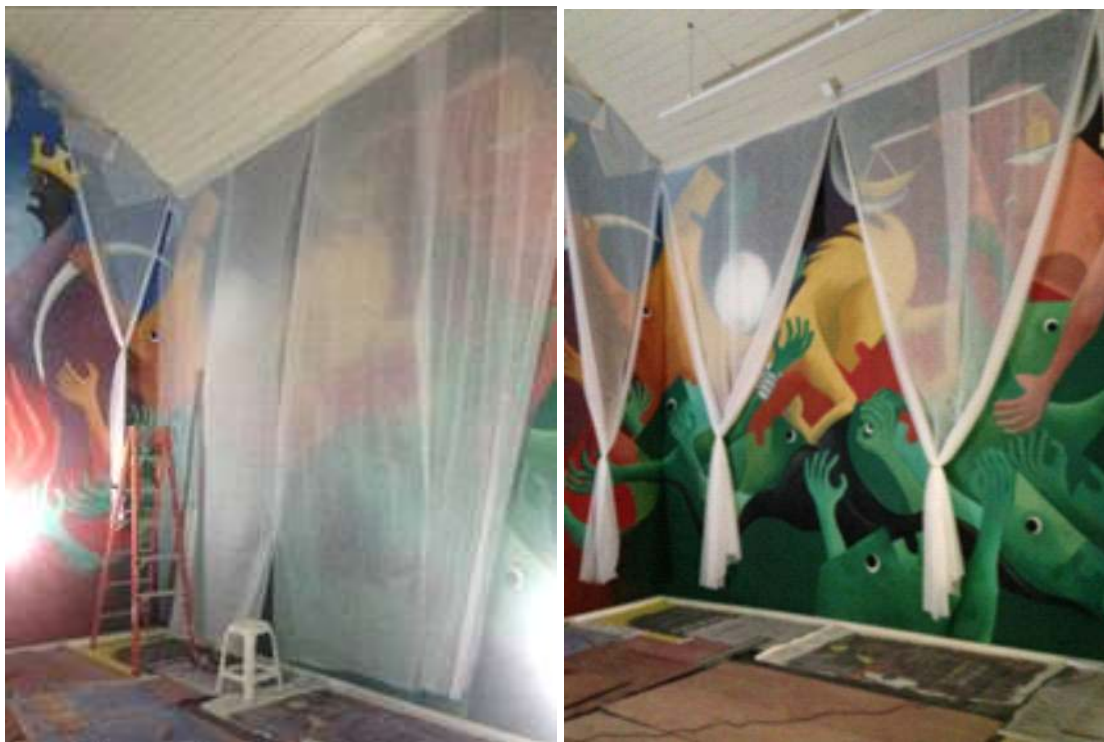
Imagem 207 - Fixação de TNT para proteção da áreas já tratadas (área superior do Mural).
