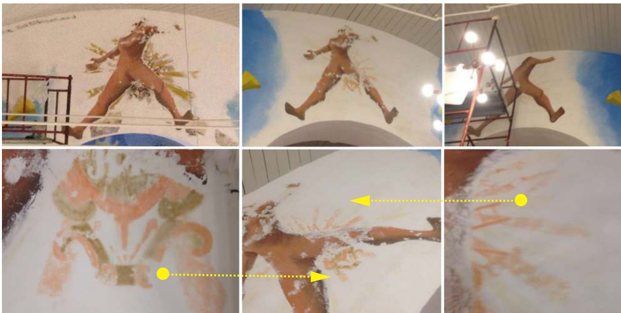
Imagem 70 - Nivelamento com massa mineral (Kroten) sobre as prospecções da pintura decorativa anterior.
