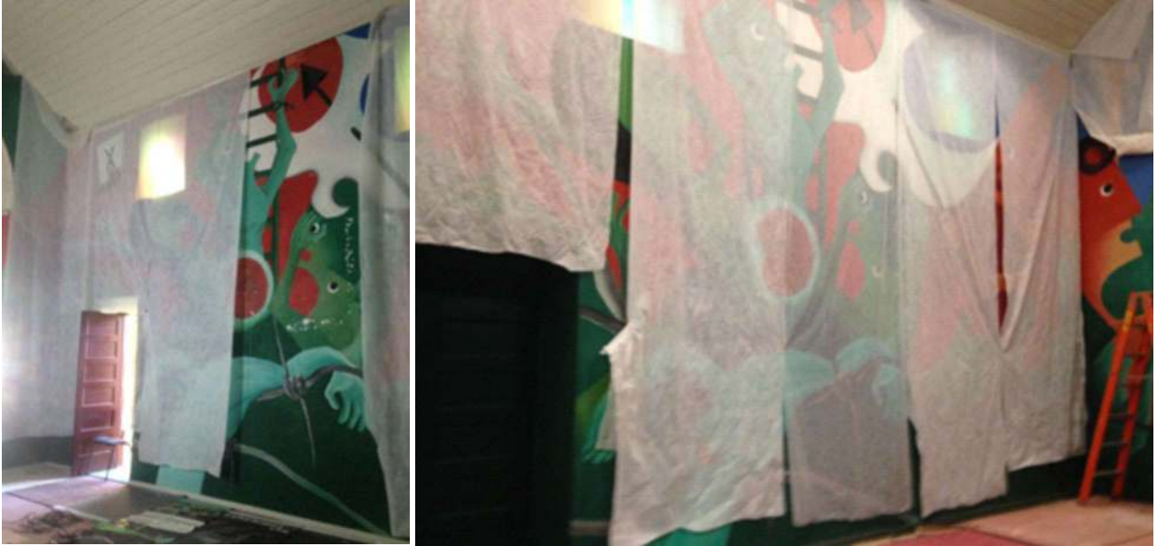
Imagem 159 - Fixação de TNT para proteção da áreas já tratadas (área superior do Mural).
