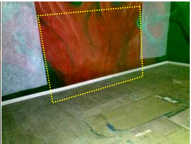
Imagem 179 - Aplicação de camada de Mowiol e colocação de roda-pé.
