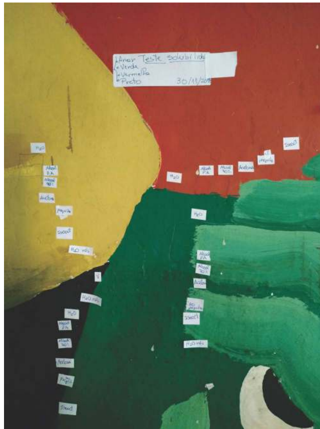
Imagem 26 - Teste de solubilidade parede lateral esquerda da Capela – Mor.
