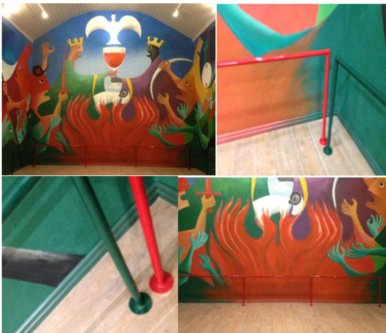
Imagem 184 - Instalação do guarda-corpo.
