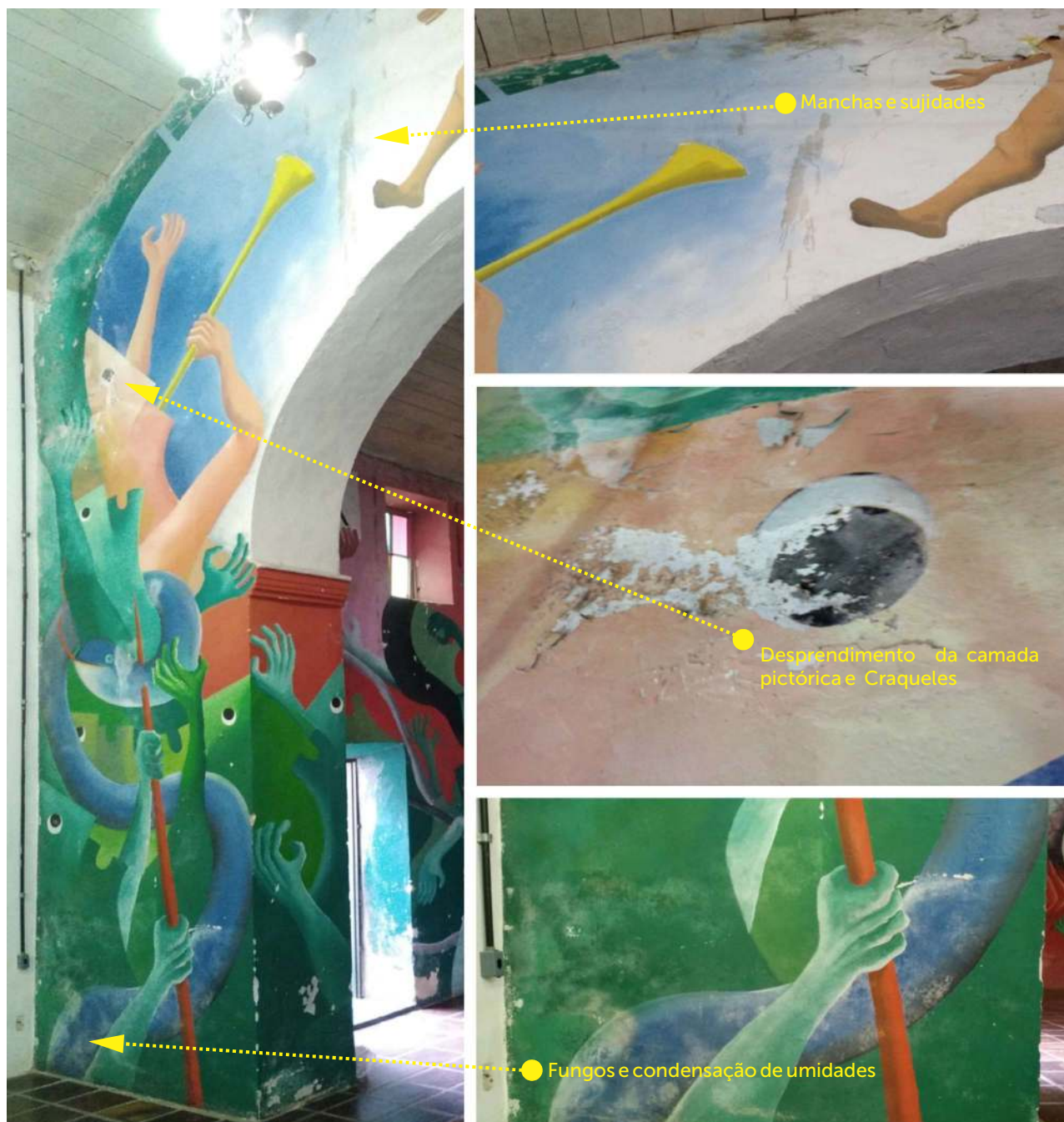
Imagem 72 - Diagnóstico do Arco Cruzeiro parede Nordeste - Frente - Esquerda
