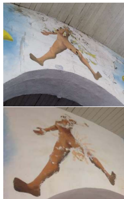
Imagem 66 - Higienização, limpeza química e mecânica da pintura mural.
