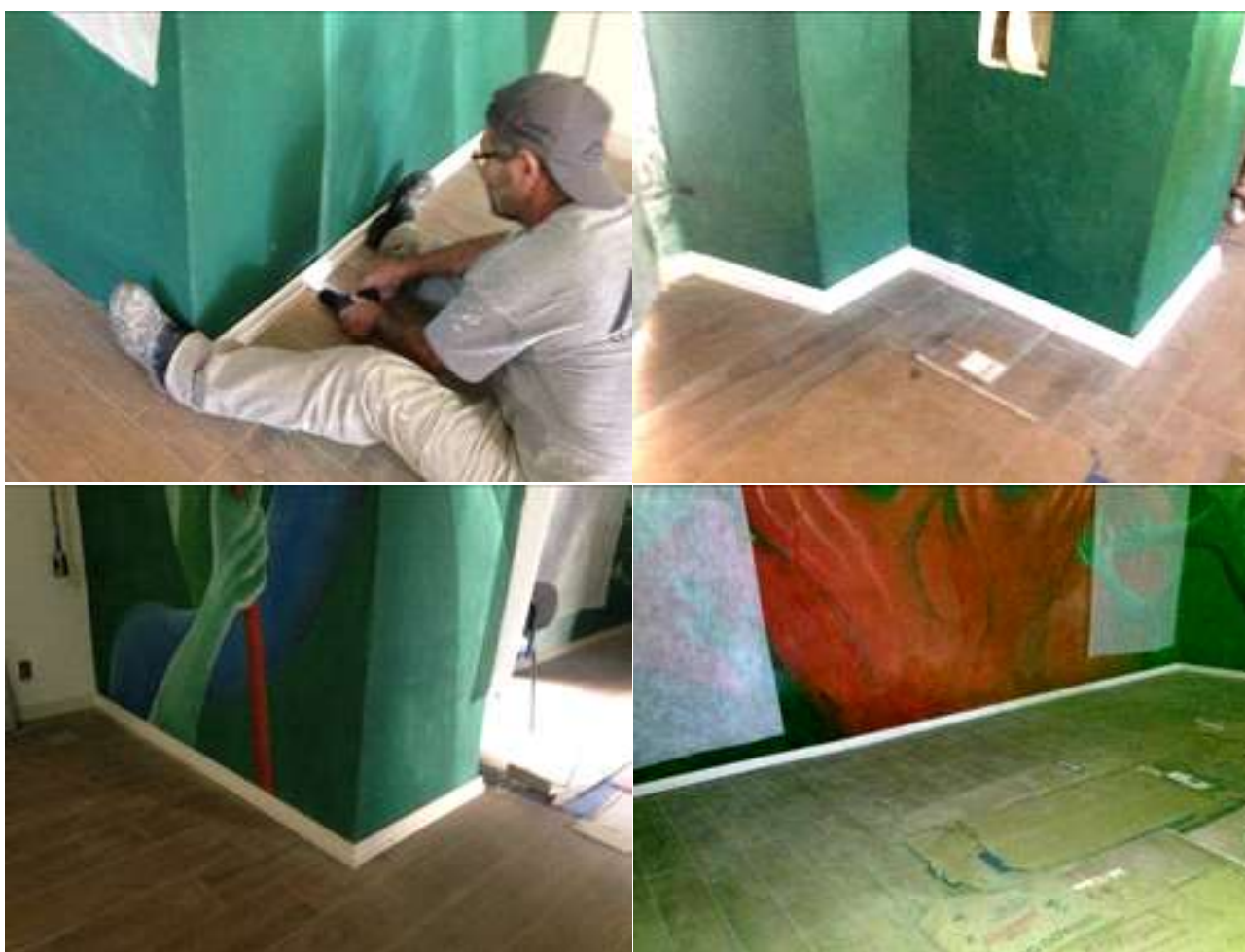
Imagem 221 - Fixação do roda-pé na Capela-Mor e Arco Cruzeiro.
