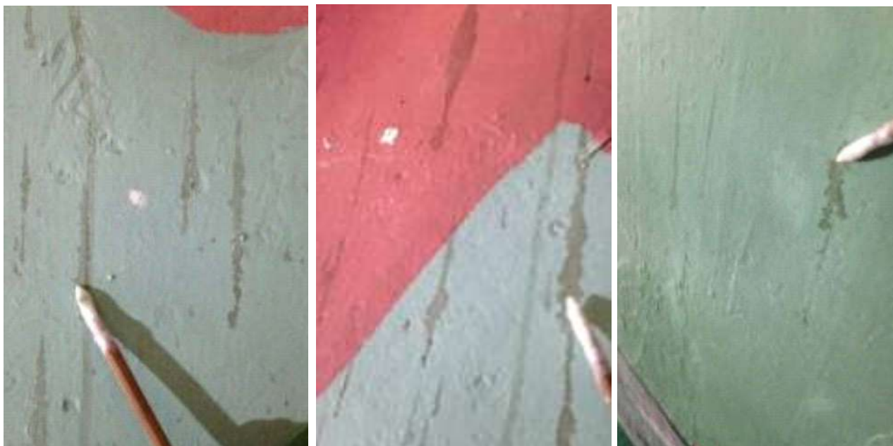
Imagem 148 - Remoção das manchas.
