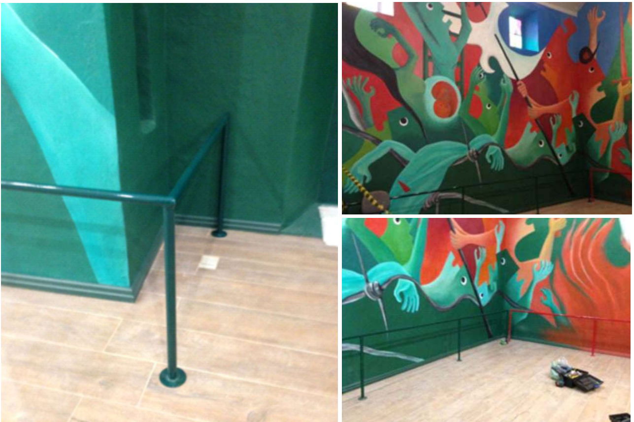
Imagem 161 - Instalação do guarda-corpo.
