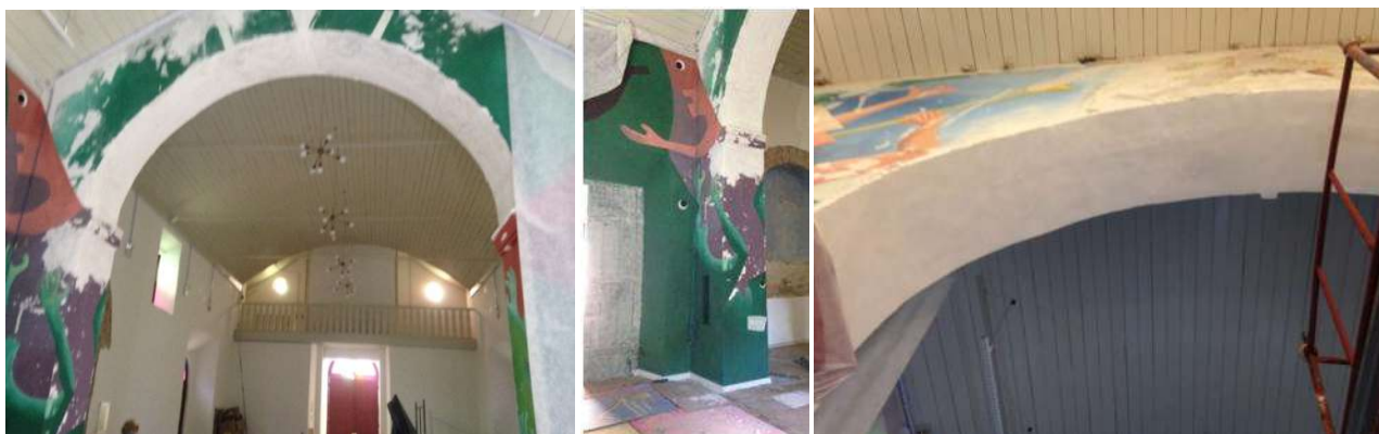
Imagem 106 - Nivelamento - aplicada massa mineral (Kroten) .
