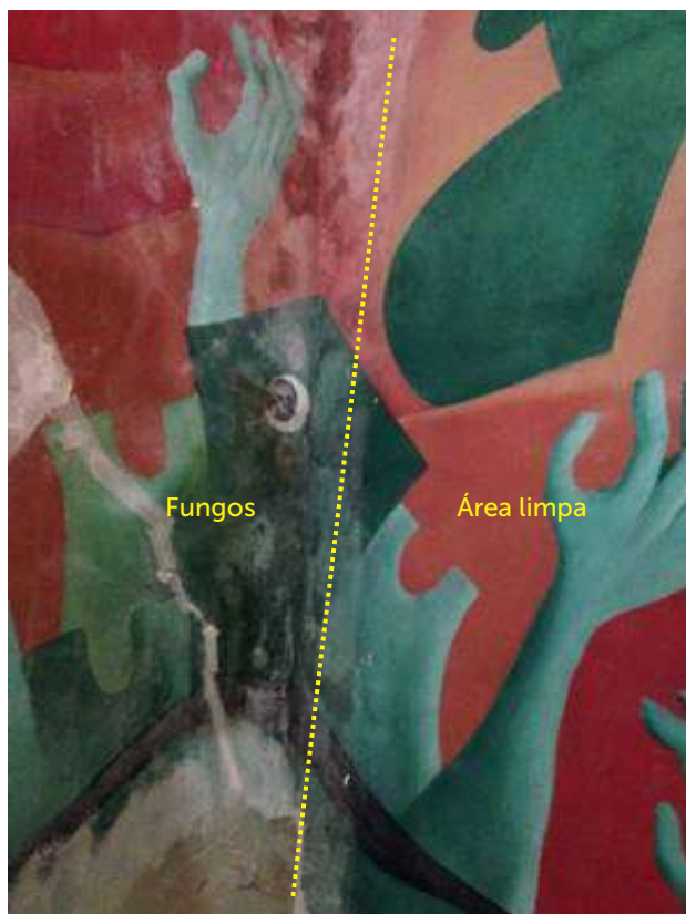
Imagem 174 - Limpeza das áreas com fungos (antes e depois).
