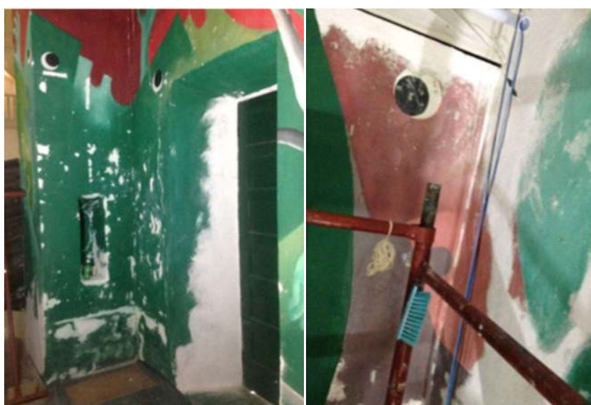
Imagem 154 - Limpeza do nivelamento.
