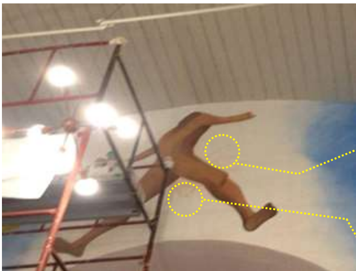
Imagem 213 - DEPOIS - nivelamento da área recobrir com massa mineral os vestígios da pintura mural decorativa anterior e pintura com tinta branca mineral.
