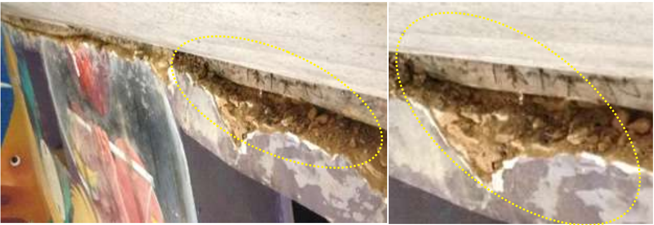
Imagem 191 - Remoção da aplicação indevida de argamassa cimento.
