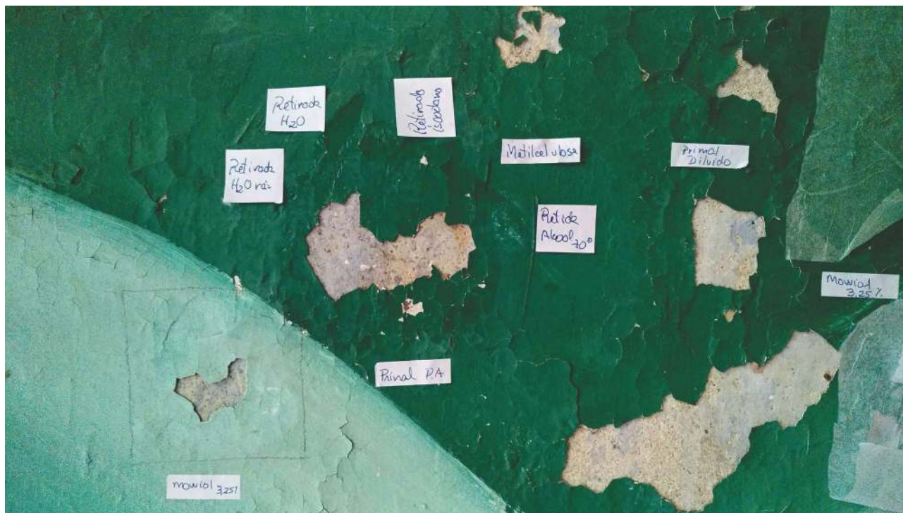
Imagem 39 - Teste de fixação parede lateral da Capela – Mor onde há craqueles em concheamento.
