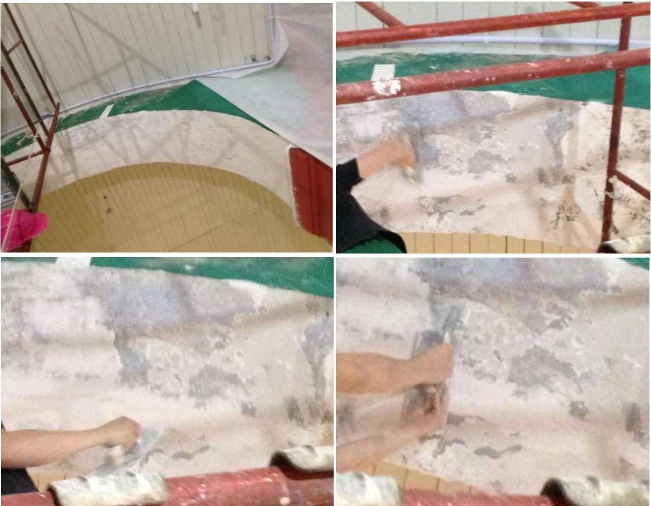
Imagem 105 - Decapagem da tinta comercial deteriorada.
