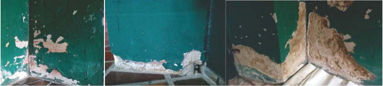
Imagem 121 - Desprendimento da camada pictórica com perdas, craqueles, abrasões, micro fissuras e fungos .
