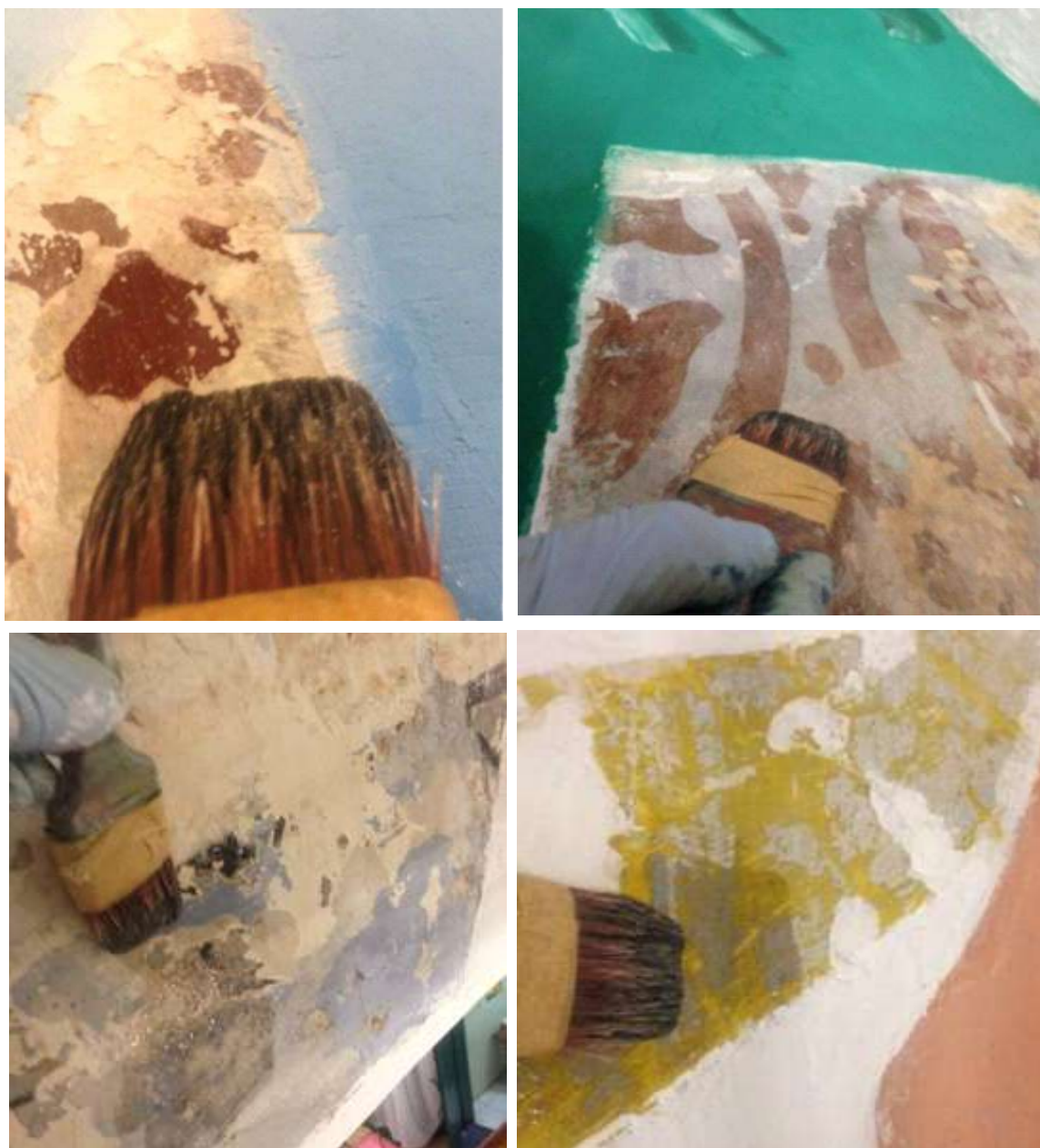
Imagem 211 - Aplicação de 3ª camada - Paralóide B 72 (10%) diluído.
