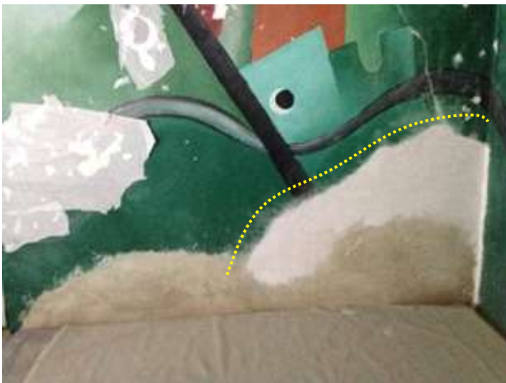
Imagem 47 - Área de intervenção – reboco e argamassa de cal.
