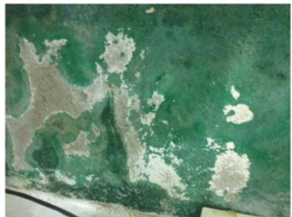
Imagem 10 - Eflorescência de sais solúveis.
