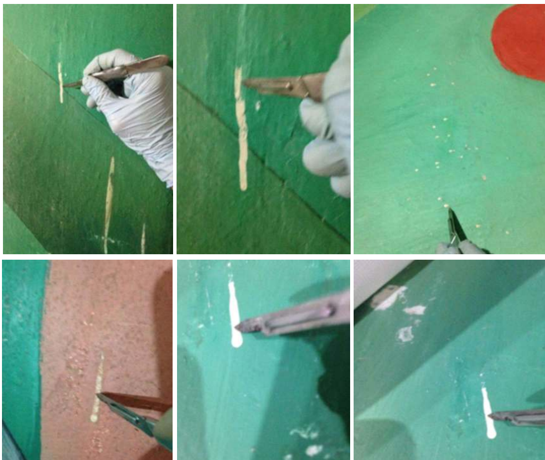
Imagem 141 - Pingos pontuais de tintas esmalte (escorridos) resultante da pintura do forro em madeira.
