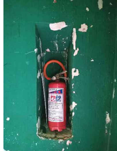
Imagem 112 - Nicho esquerdo (usado inadequado do nicho como suporte para extintor) foto:06/12/2018.
