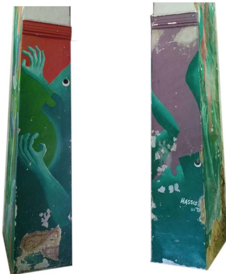
Imagem 96 - Arco Cruzeiro - Parede Nordeste - Interna
