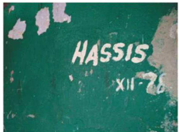
Imagem 09 - Argamassa de cimento.
