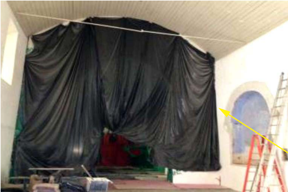
Imagem 55 - Proteção do Arco Cruzeiro com a lona plástica (preta).
