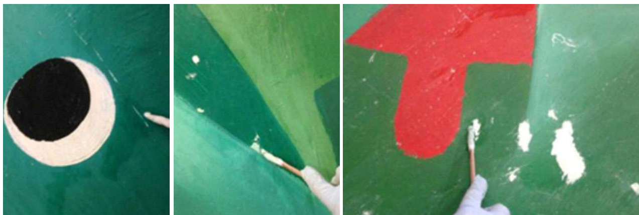
Imagem 152 - Limpeza do nivelamento.
