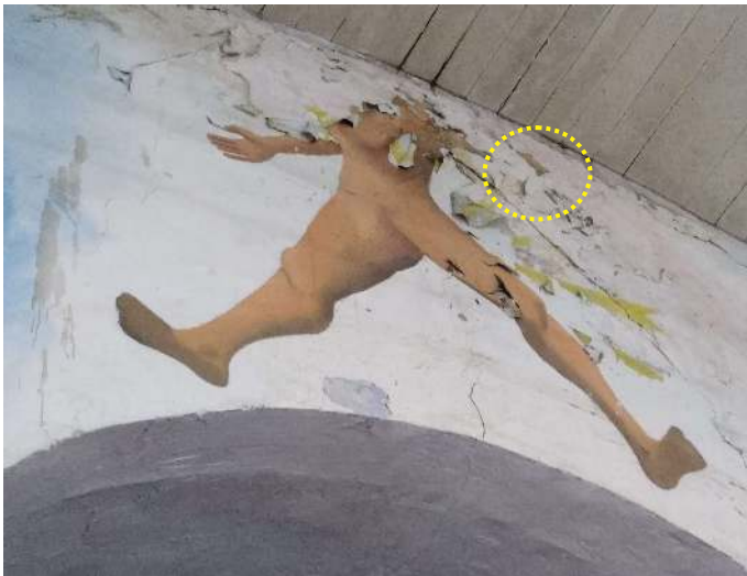
Imagem 217 - Antes do restauro.
