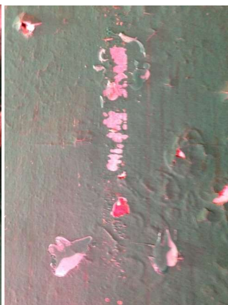
Imagem 117 - Craquelês generalizados e marcas de pregos fixados.
