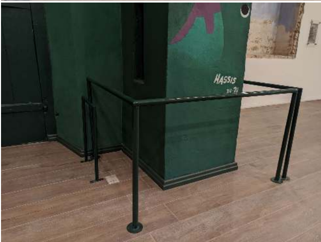
Imagem 227 - Instalação do guarda-corpo finalizada (barra/corrimão) para proteção da pintura mural.
