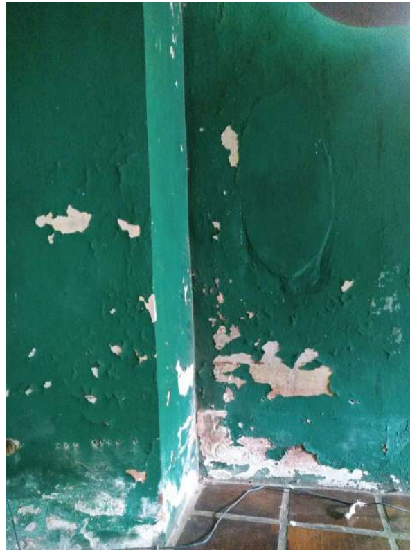
Imagem 117 - Craquelês generalizados e marcas de pregos fixados.
