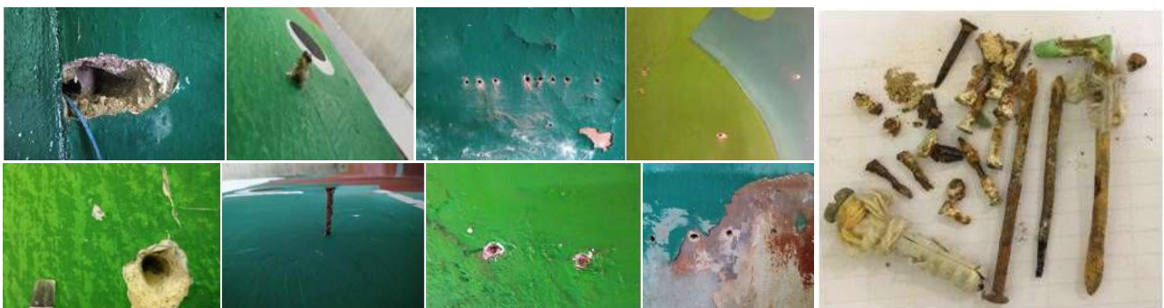
Imagem 44 - Remoção dos pregos oxidados.
