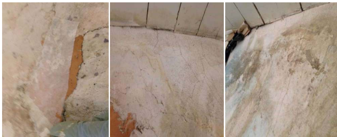
Imagem 58 - Sujidades acumulada, manchas e áreas em desprendimento.
