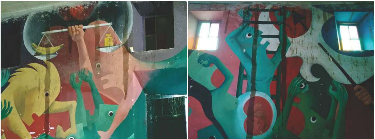
Imagem 19 - Acúmulo de poeira e sujeira superficial.
