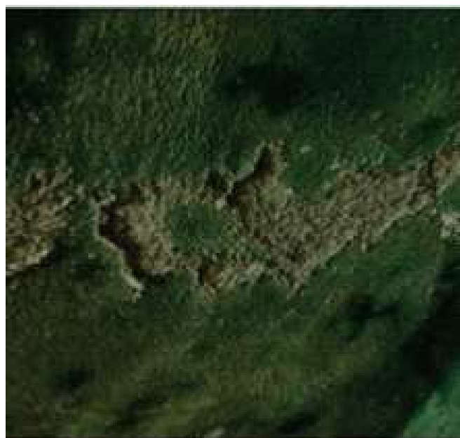
Imagem 168 - Presença de eflorescência de sais na lateral esquerda da parede (fundos da Capela - Mor).
