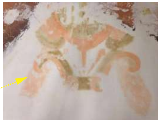
Imagem 212 - ANTES - vestígios da pintura mural decorativa anterior recobertas no Arco Cruzeiro parede nordeste (frente-área central).
