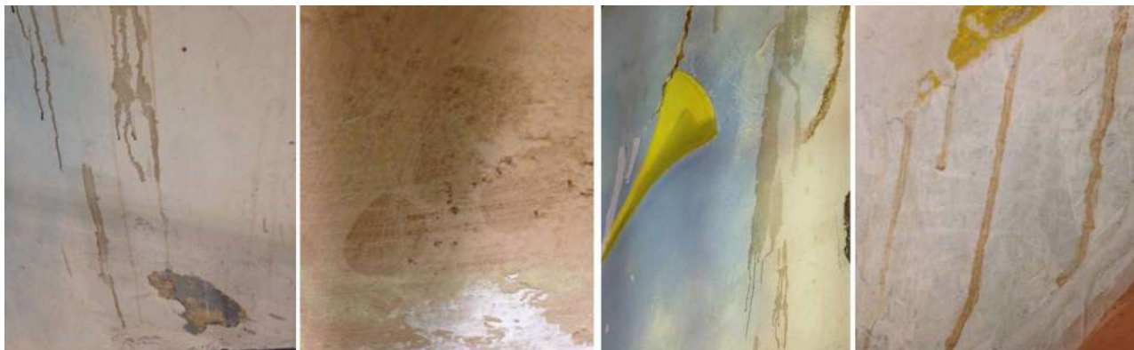
Imagem 61 - Manchas e escorridos sobre a pintura mural - parede do Arco Cruzeiro .
