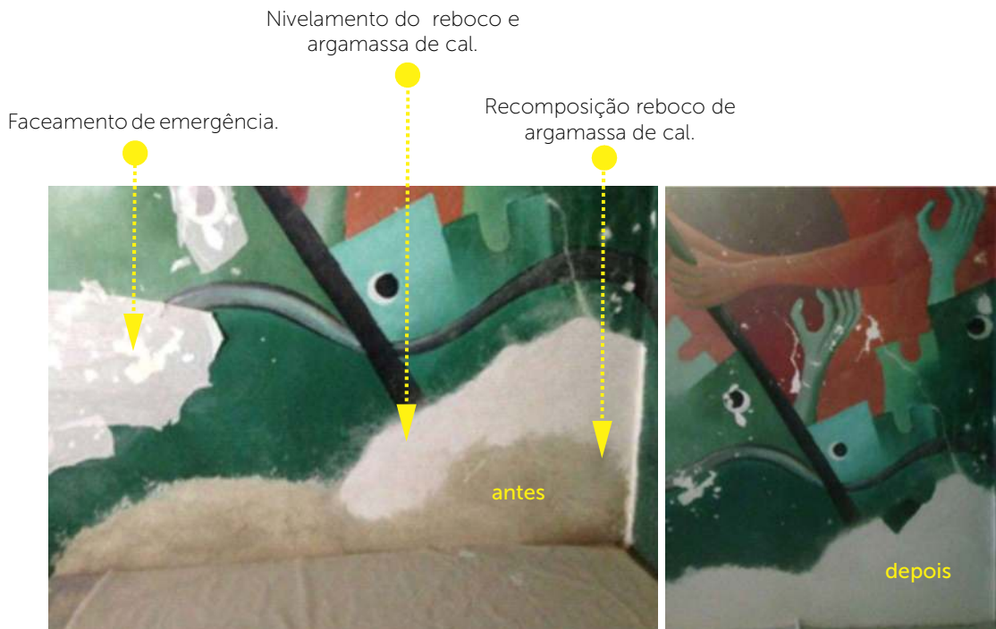
Imagem 151 - Reintegração na área de lacuna cromática que foi nivelada com argamassa de cal- (tinta mineral encomendada à Empresa Kroten).
