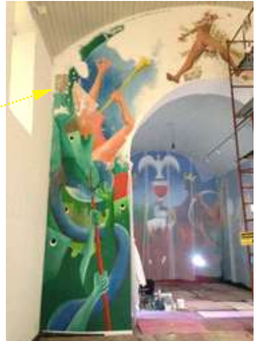
Imagem 210 - Registro dos vestígios da pintura mural decorativa anterior do Arco Cruzeiro parede nordeste (frente – lado esquerdo).
