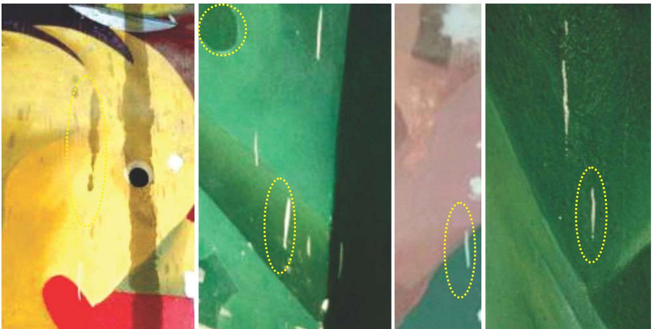
Imagem 193 - Pingos pontuais de tintas esmalte (escorridos) resultante da pintura do forro em madeira.
