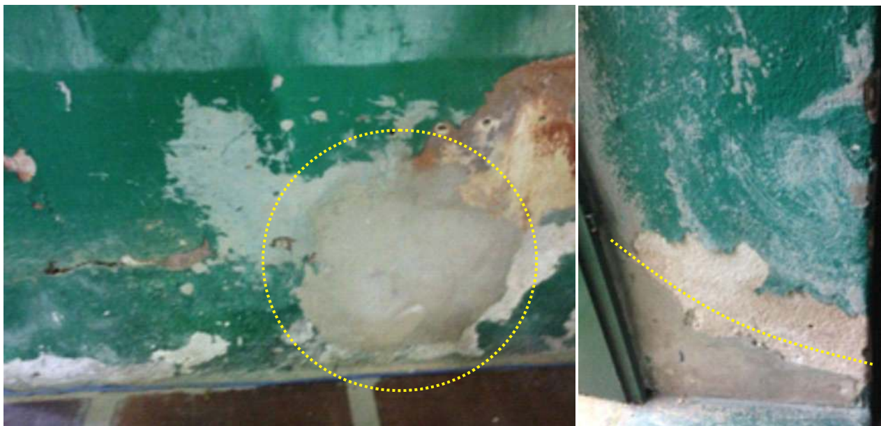
Imagem 137 - Aplicação indevida de argamassa cimento que foi removido.
