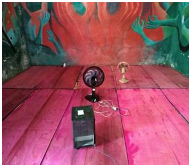
Imagem 167 - secagem da parede (ventilação forçada para eliminar excesso de umidade na parede- com ventiladores e desumidificador).
