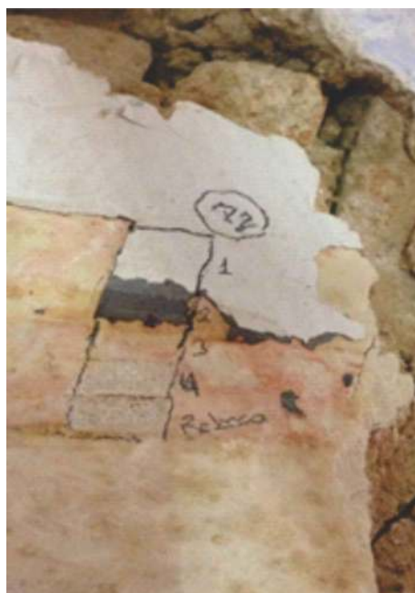
Imagem 22 - Janela estratigráfica – prospecção 2 (P2) no centro do Arco Cruzeiro. A P2 identifica o reboco e 4 camadas de pinturas seqüenciais.
