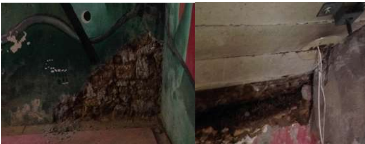
Imagem 138 - Remoção da aplicação indevida da argamassa de cimento.
