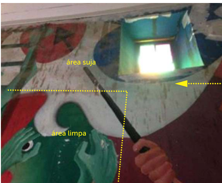
Imagem 147 - Higienização, limpeza química e mecânica da pintura mural.
