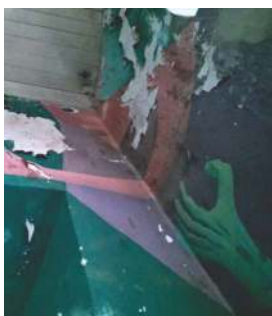
Imagem 114 - Manchas e sujidades.
