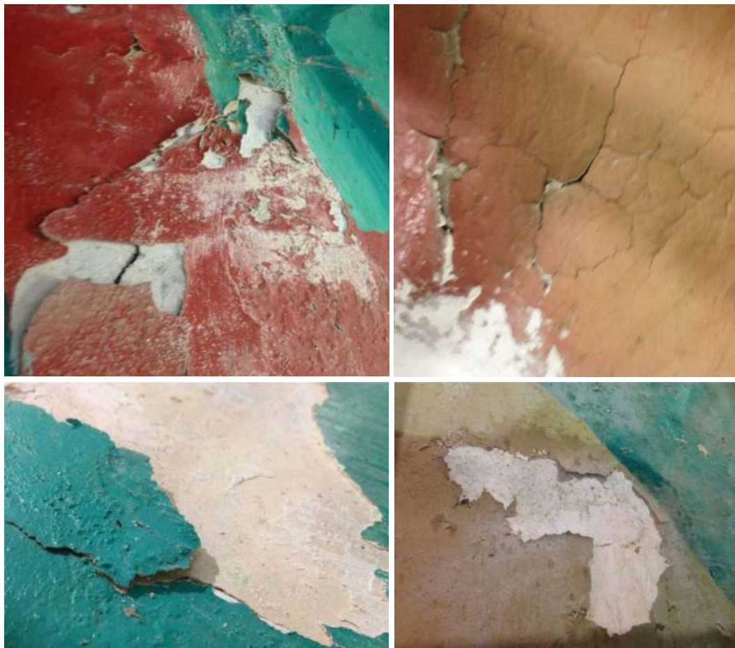
Imagem 59 - Craquelamentos generalizados na parede esquerda e pontual na parede lateral direita - Arco Cruzeiro .
