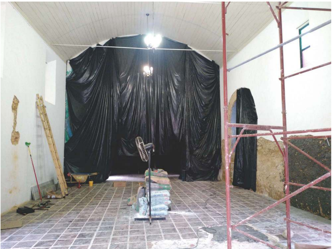
Imagem 20 - Proteção do Arco Cruzeiro com a lona plástica (preta).
