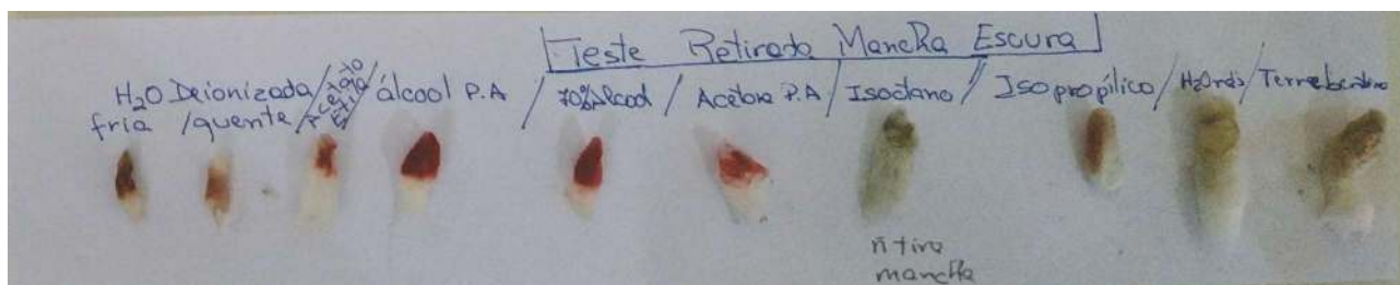
Imagem 35 - Teste de remoção da mancha escura com produtos químicos, parede da Capela – Mor.
