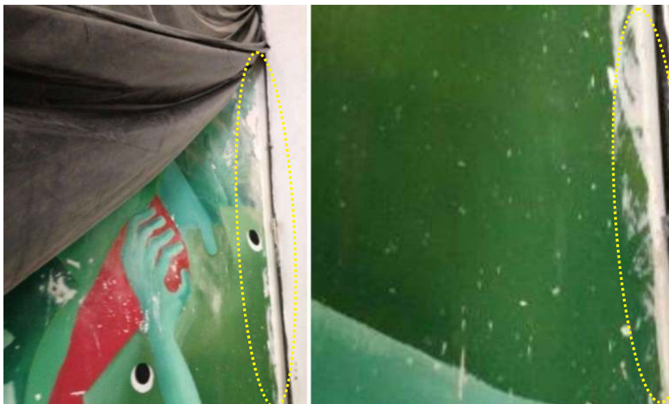
Imagem 56 - Respingos e resíduo de tintas resultante da pintura do forro em madeira da Capela Mor e também nas paredes adjuntas ao Arco- Cruzeiro. Respingos de tinta comercial generalizados nas laterias.
