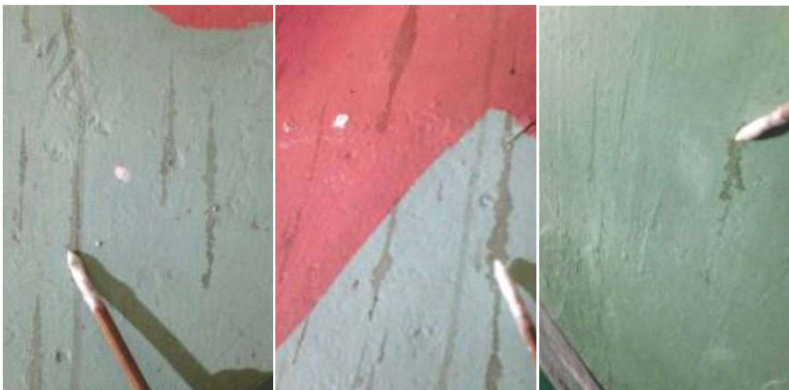
Imagem 199 - Remoção de manchas.
