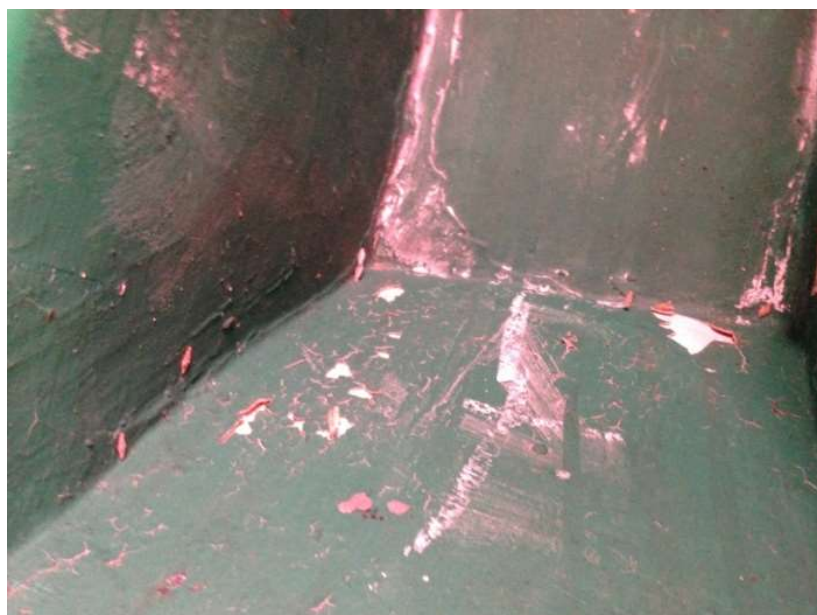
Imagem 118 - Abrasões, micro fissuras e craquelês (dentro do nicho esquerdo).
