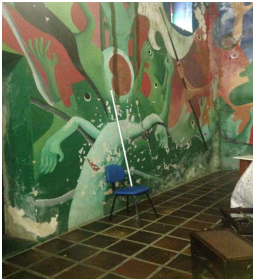
Imagem 140 - Material encostado no mural – causando patologias e deterioração do Mural.
