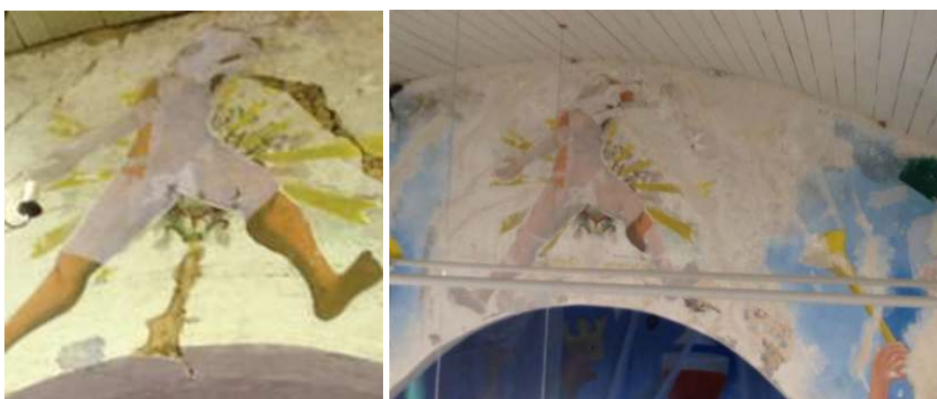
Imagem 65 - Faceamento de emergência.
