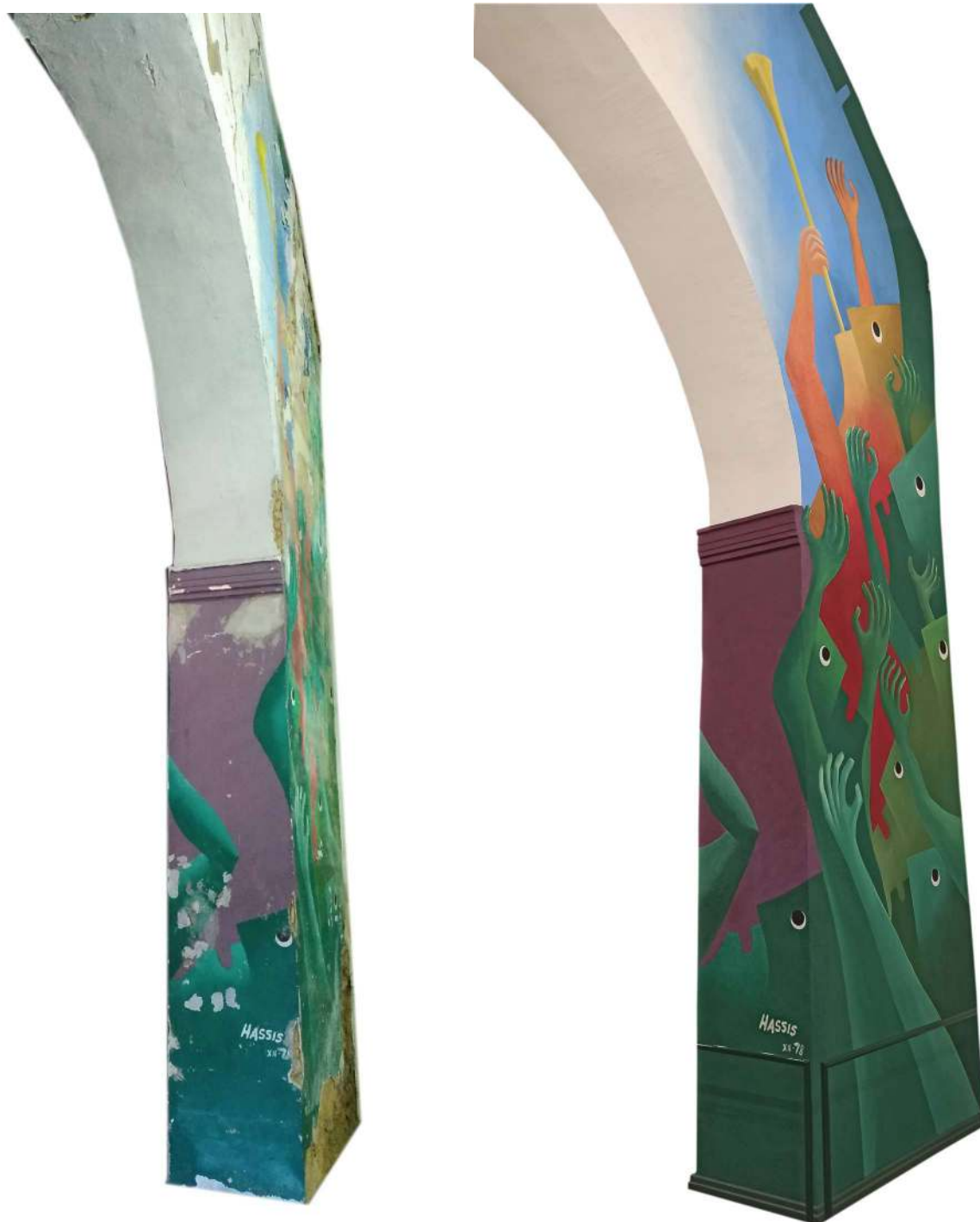
Imagem 95 - Arco Cruzeiro - Parede Nordeste Interna Esquerda - Antes e depois do restauro.
