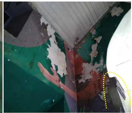
Imagem 112 - Nicho esquerdo (usado inadequado do nicho como suporte para extintor) foto:06/12/2018.
