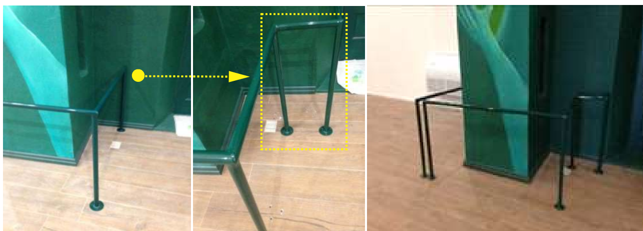
Imagem 226 - Reinstalação do guarda-corpo (barra/corrimão).
