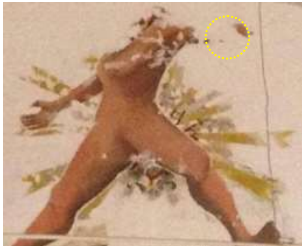
Imagem 215 - Restauro - fase de nivelamento.
