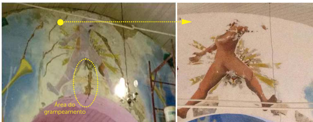
Imagem 67 - Antes e Depois do nivelamento massa mineral das áreas com ruptura (profunda) e da retirada de reboco de cimento.
