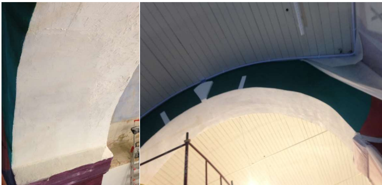
Imagem 107 - Pintura da parede interna com tinta branca mineral (Empresa Kröten) .
