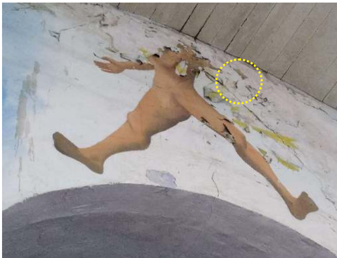
Imagem 214 - Antes do restauro.
