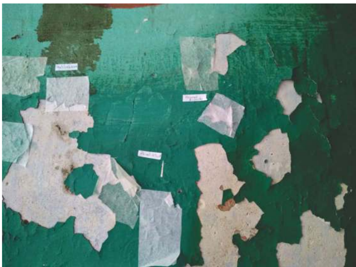
Imagem 37 - Teste de faceamento emergencial.
