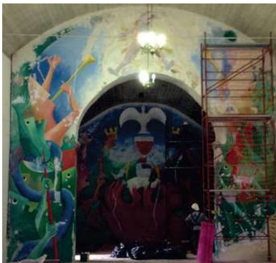
Imagem 64 - Arco Cruzeiro e suas patologias
