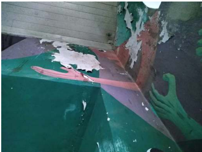
Imagem 116 - Desprendimento da camada pictórica com perdas e craqueles.
