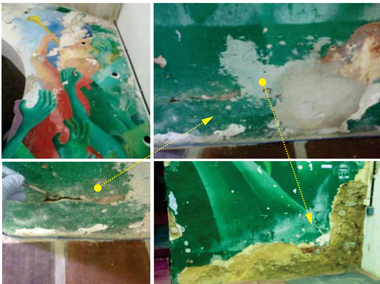
Imagem 83 - Remoção das áreas com intervenções inadequadas (argamassa de cimento).
