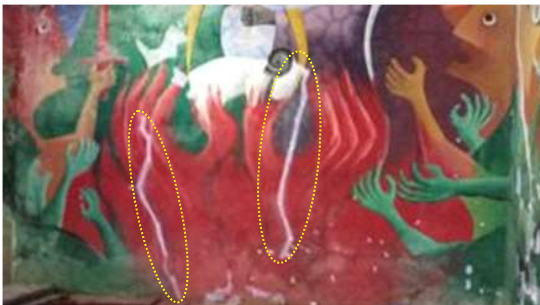
Imagem 170 - Faceamento de emergência .
