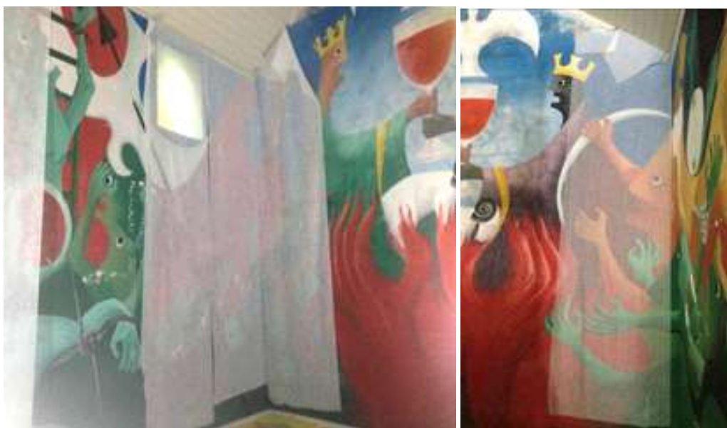
Imagem 181 - Colocação do TNT para proteção das áreas já tratadas (área superior do Mural).
