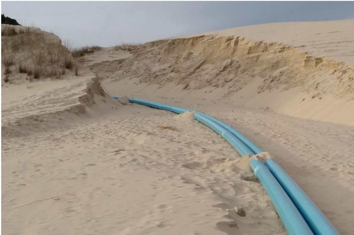
Foto 1: Tubos instalados para transporte e liberação de efluente sobre ecossistemas naturais no Parque Natural Municipal das Dunas da Lagoa da Conceição. Notar corte feito na duna, o que tem gerado processos erosivos e carreamento de sedimentos a jusante.
