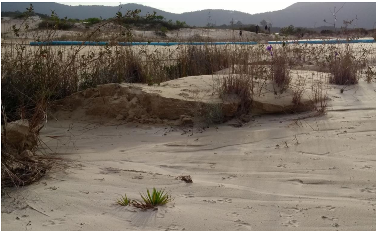
Foto 2: Carreamento de sedimentos e soterramento da vegetação de restinga decorrentes do corte da duna para instalação de tubulação para a liberação de efluente no Parque Natural Municipal das Dunas da Lagoa da Conceição.
